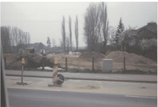
Die Anfüllung der Wiese mit Kies aus dem Bodenaushub vom Neubau des Hildener Rathauses
