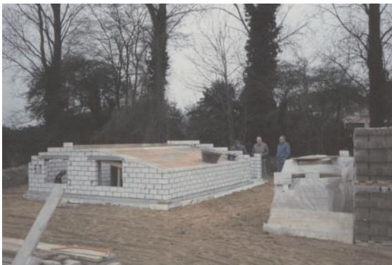
Das Kellergeschoss des Schießstandes
