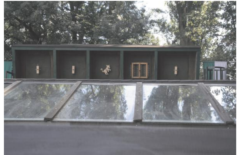
Schießstand: Eingebautes Lichtband aus Sicherheitsglas im Vordach des Hochstandes
