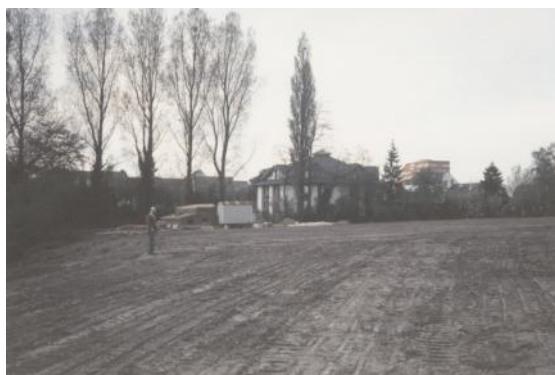
Nachdem alles planiert war, wurde der Mutterboden aufgebracht
