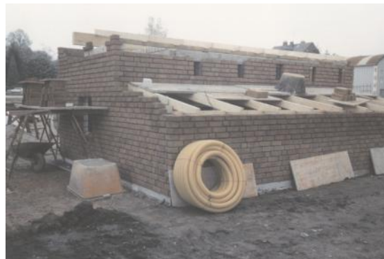
Der verklinkerte Rohbau
