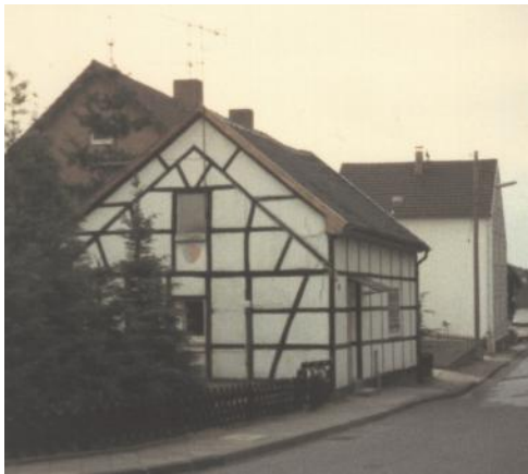
Fachwerkhaus in der Flachskampstraße
