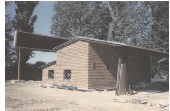
Das fertige Gebäude mit Kugelfang
